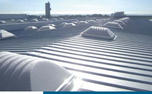
Os domus prismáticos ocupam em média 3% da estrutura total do telhado; cada tipo de cobertura exige uma instalação feita sob medida, conforme o projeto luminotécnico
